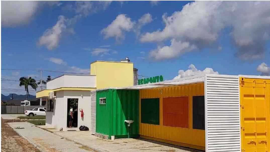
Imagem 8 – Construção do Eco Ponto
