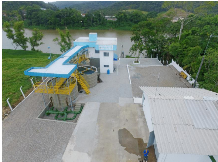
Vista aérea da ETA II,
