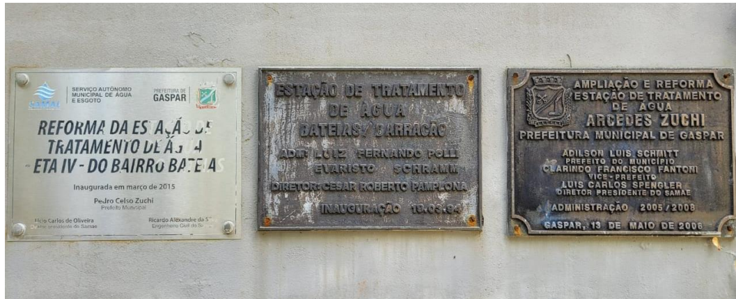
IMAGEM 32 – PLACAS COM AS DATAS DE REFORMA E INSTALAÇÃO DA ETA IV - BATEIAS
