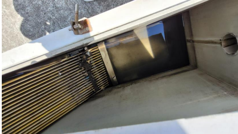
IMAGEM 71 – VISTA DO GRADEAMENTO DA ETE MARGEM ESQUERDA
