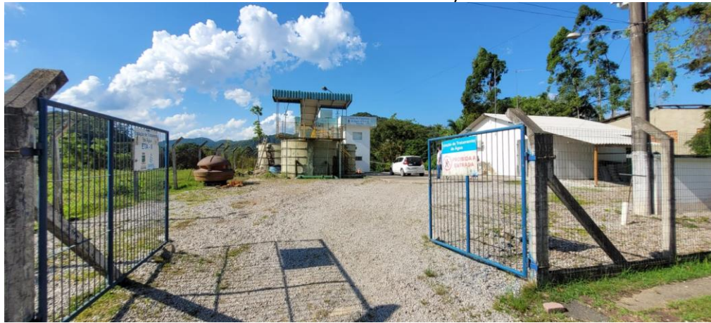
Vista do portão de acesso da ETA II.
