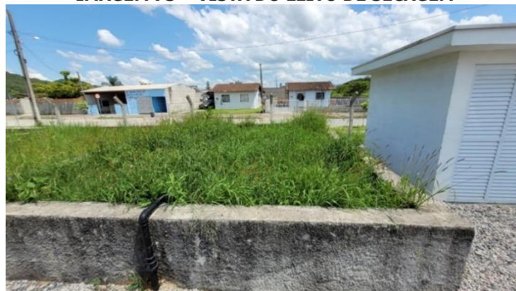
IMAGEM 73 – VISTA DO LEITO DE SECAGEM
