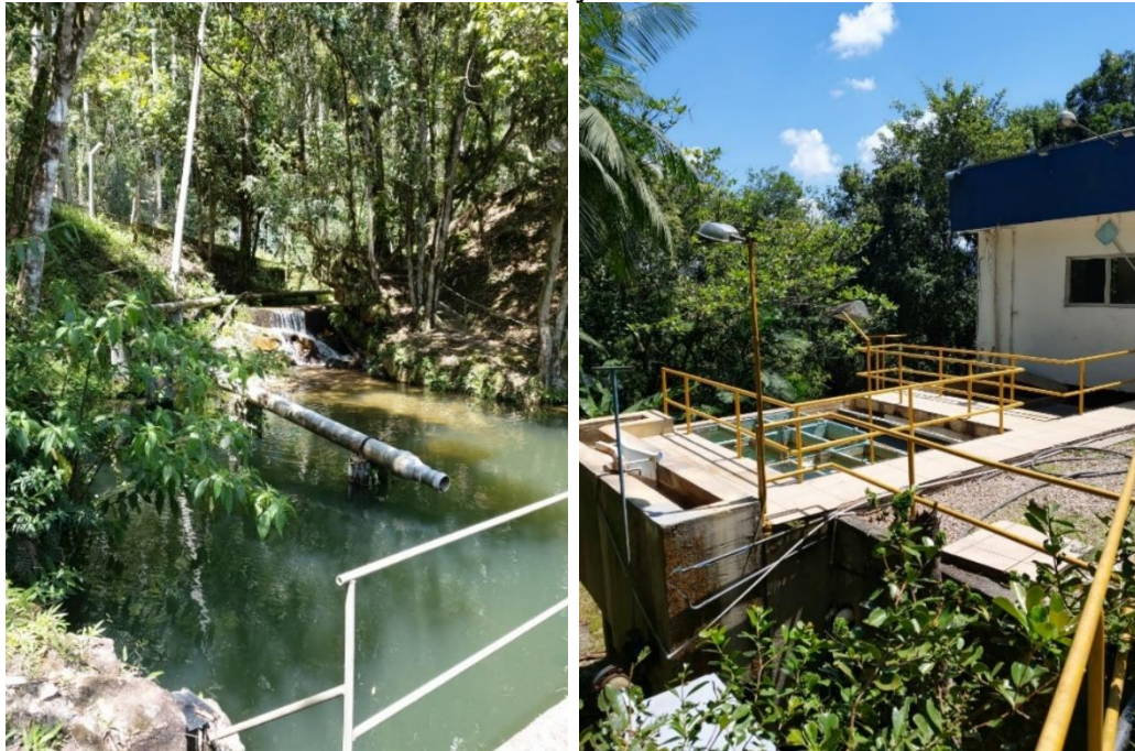
Vista da captação e da ETA IV.
