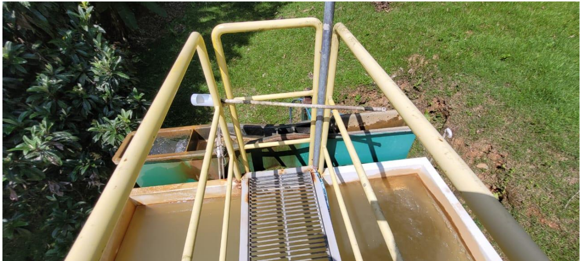
Vista da entrada da ETA V com a Calha Parshall.
