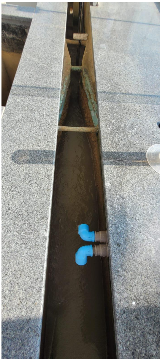
Vista da calha parshall da ETA II.
