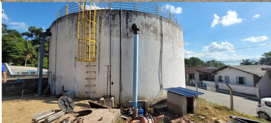
Fonte: Motta Martins Engenharia Ltda.
