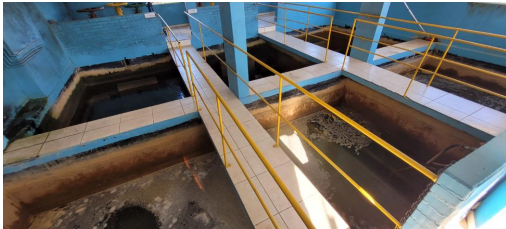
Vista das etapas de filtração da ETA I.
