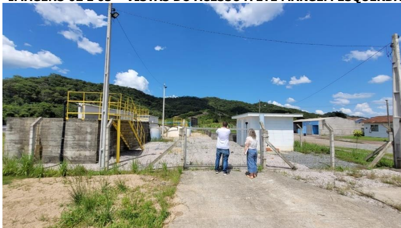
IMAGENS 62 E 63 – VISTAS DO ACESSO A ETE MARGEM ESQUERDA
