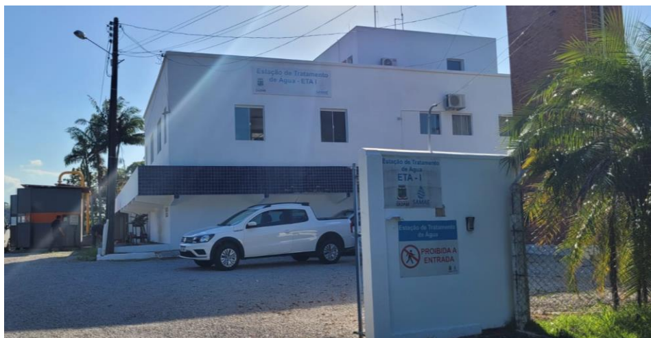
Vista do portão de entrada da ETA I.
