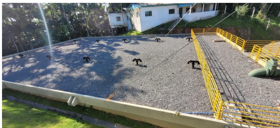
Vista do reservatório da ETA I. Fonte: Motta Martins Engenharia Ltda.
