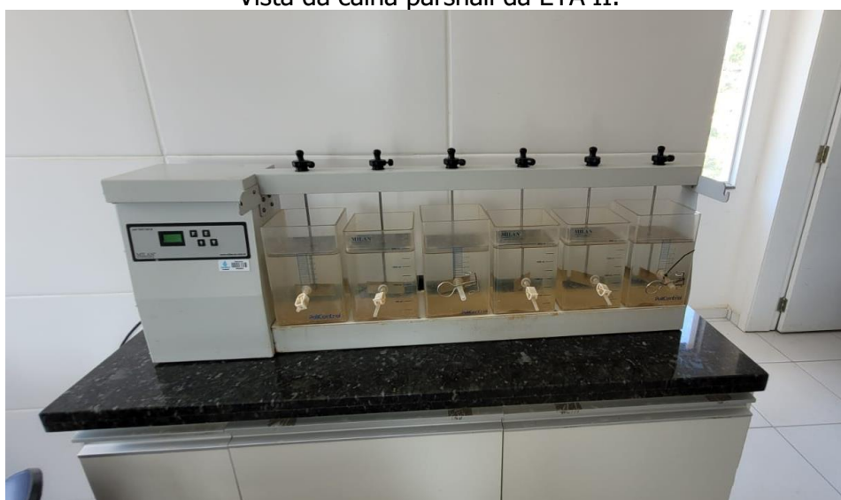
Vista do Jar Test no laboratório da ETA II.
