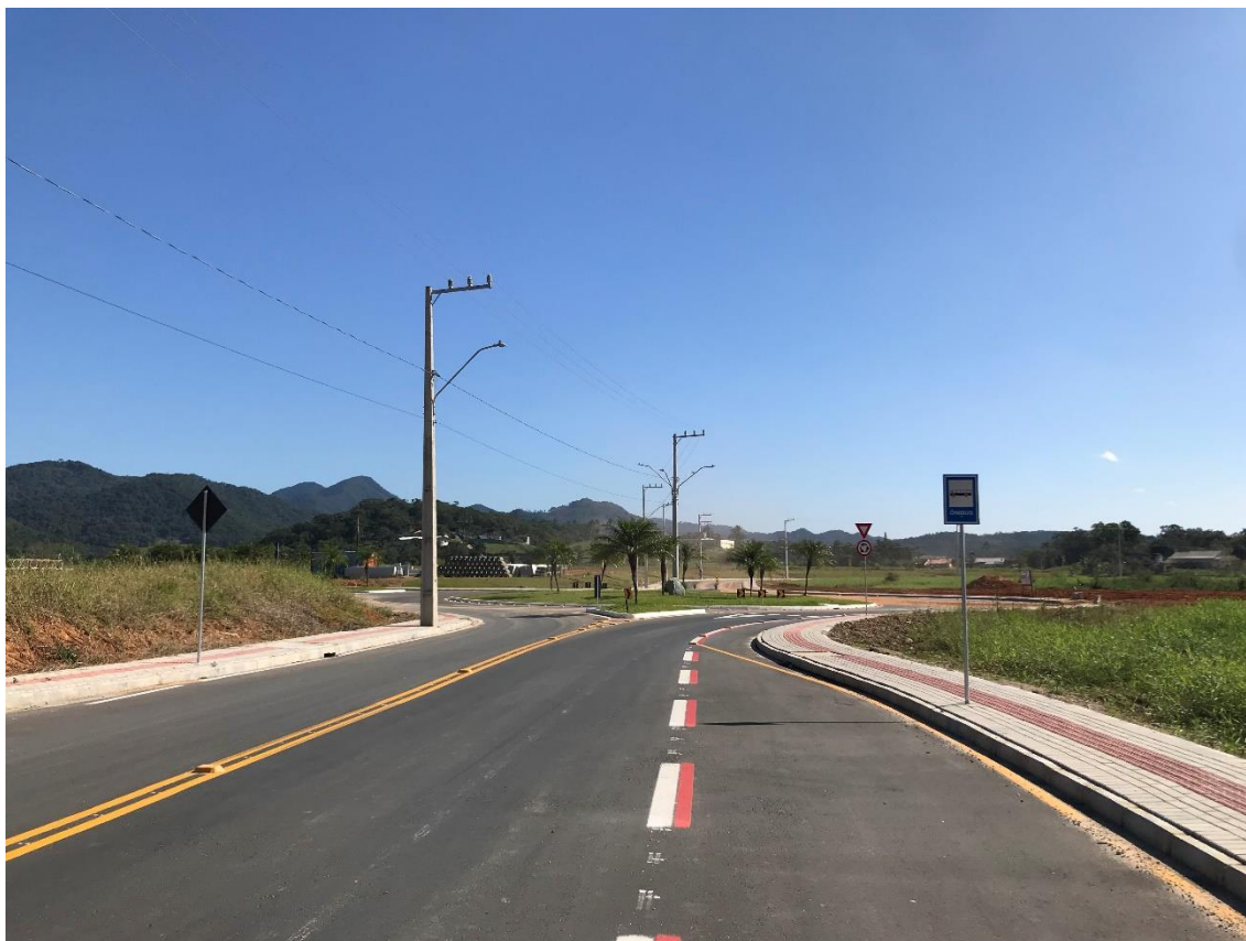
FIGURA 14 – RÓTULA EM FRENTE AO EMPREENDIMENTO. FONTE: O AUTOR.
