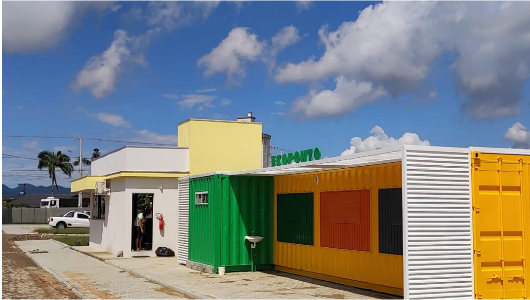
Imagem 29 – Construção do Eco Ponto
