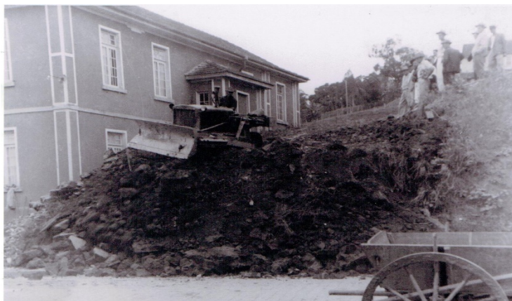
Terraplanagem do morro para construção da escadaria.
