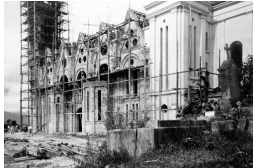
Igreja Matriz em construção. Alguns antigos jazigos do cemitério, os andaimes armados com ripas de palmeiras, pregos e fitas de aço.
