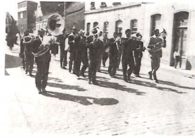
Desfile da Independência em 1950 na rua Cel. Aristiliano Ramos, em frente a casa de D. Holdina Wehmuth
