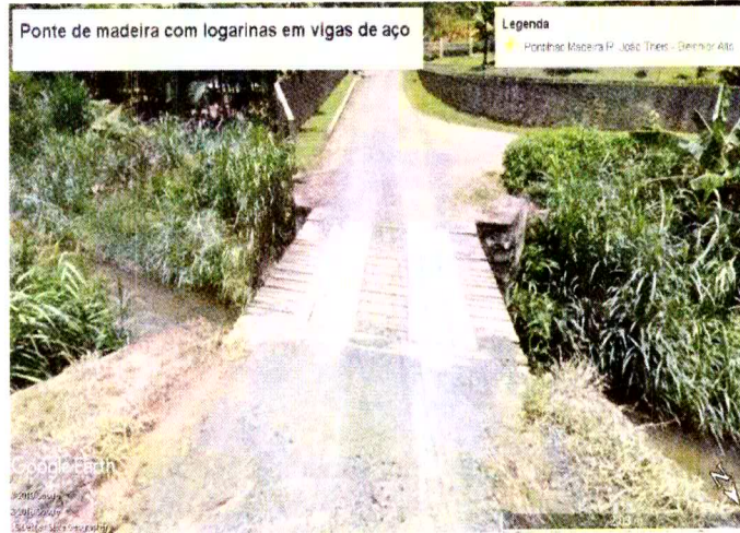
Foto 02 – Vista Frontal: Via Pública /Ponte de Madeira
