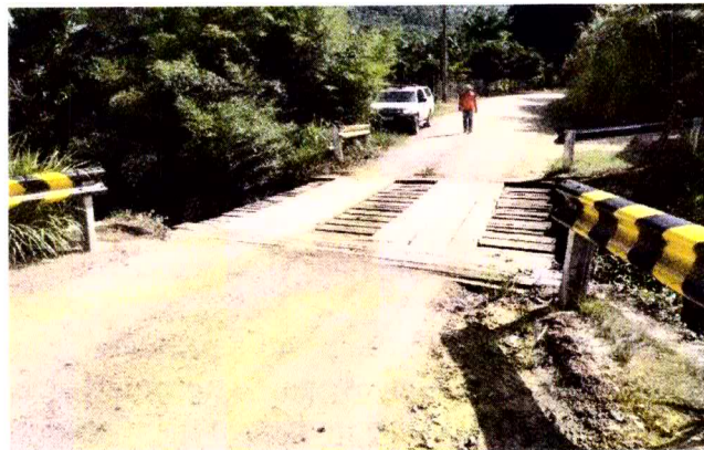
Foto 03 – Detalhe da Ponte de Madeira – Indicação na imagem de possível rebaixo no tabuleiro.
