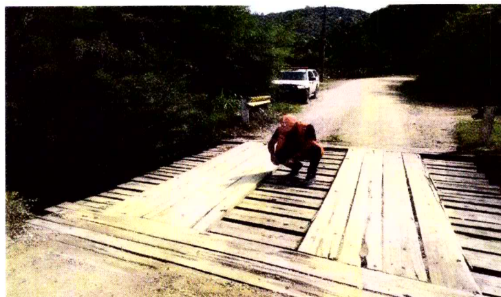
Foto 03 – Detalhe da Ponte de Madeira – Indicação na imagem de possível rebaixo no tabuleiro.
