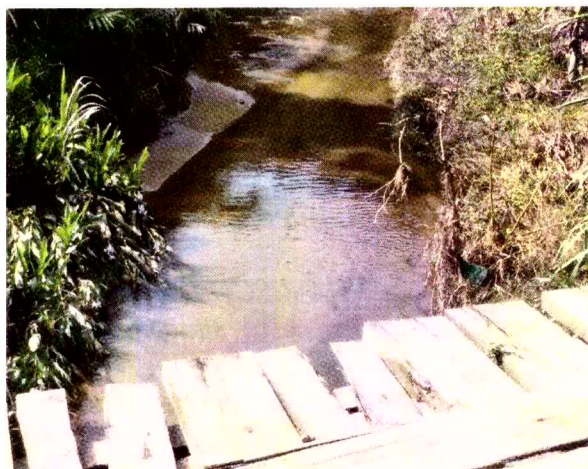
Foto 05 – Indicações com peças fadigadas e danificadas devido corrosão das peças
