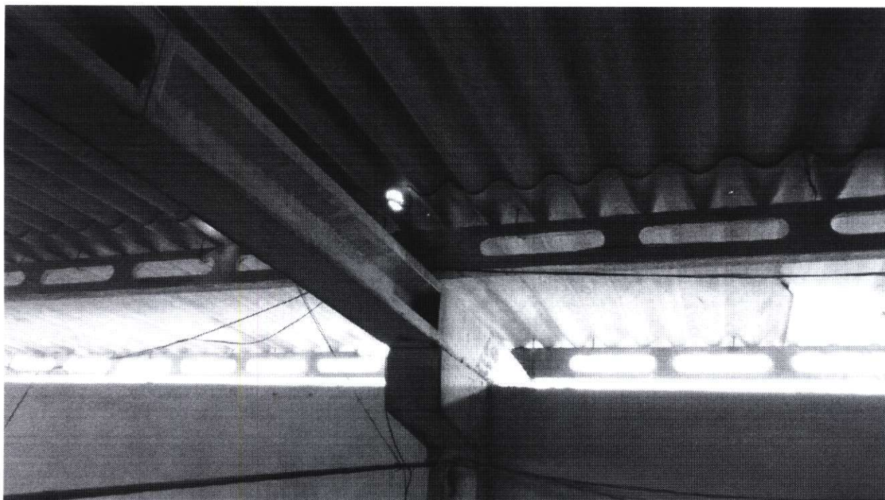
Foto 7 – telhado danificado
