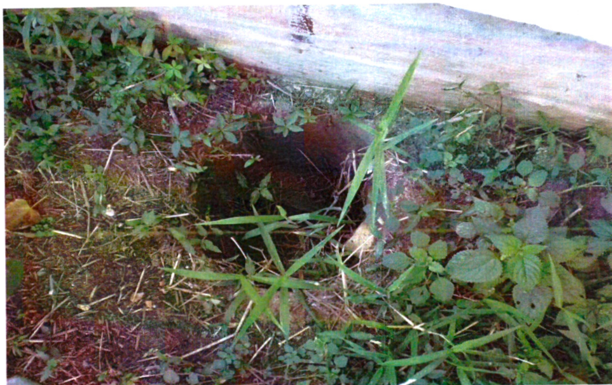
FOTOGRAFIA 4 – Acesso a tubulação que corta o lote, localizada no rumo dos fundos na extrema direita do terreno.
