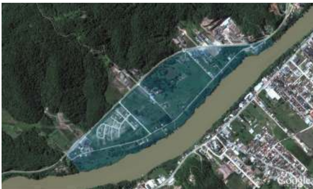
Figura 0.2 – Imagens da situação atual do Loteamento Master Plan e a rua Carlos Roberto Schramm
