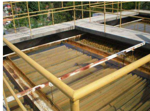
Figura 23 – Vista parcial das unidades de decantação, à direita, detalhe do decantador, mostrando o sistema laminar. Fonte: SAMUSA (2009).
