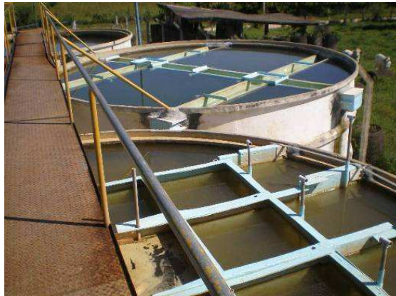
Figura 26 - Vista de um dos blocos hidráulicos da ETA II (unidades de floculação, decantação e filtração). Fonte: SAMUSA (2009).
