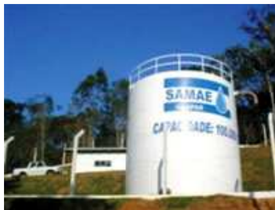
Figura 32 – Vista geral da ETA VI. Fonte: SAMUSA (2009).
