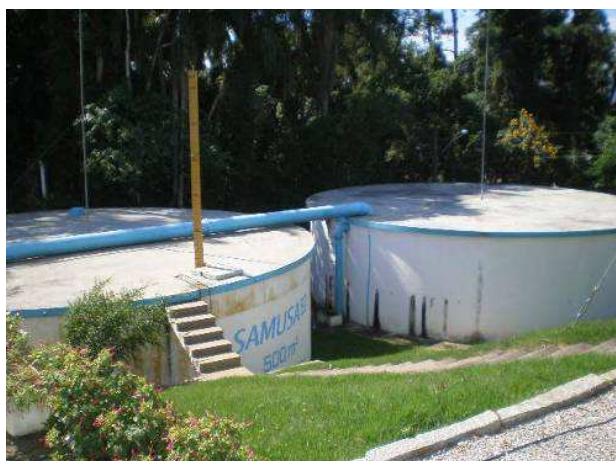
Figura 25 - Vista dos reservatórios de acumulação. Fonte: SAMUSA (2009).
