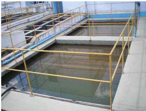
Figura 23 – Vista parcial das unidades de decantação, à direita, detalhe do decantador, mostrando o sistema laminar. Fonte: SAMUSA (2009).
