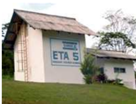
Figura 30 – Vista geral da ETA V, no bairro Belchior, hoje desativada. Fonte: SAMUSA (2009).
