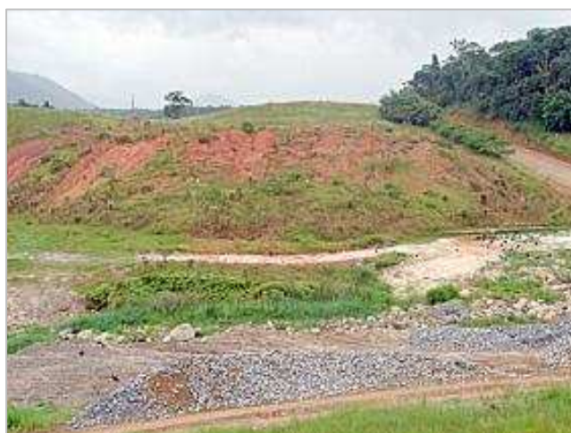
Figura 34 – Aterro sanitário de Timbó/SC. Fonte: Fonte: Jornal do Médio Vale, 13/02/09.
