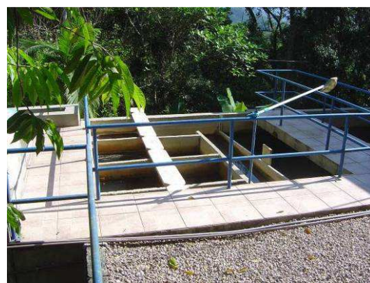
Figura 29 – À esquerda vista geral da sala de operação da ETA IV; à direita vista da unidade de tratamento (floculadores e decantador).
