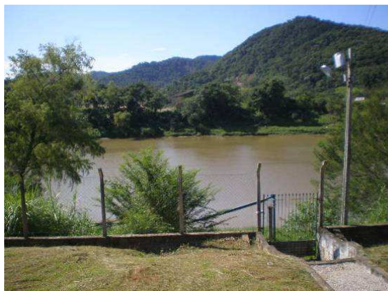
Figura 27 - Vista do manancial de captação de água da ETA II. Fonte: SAMUSA (2009).
