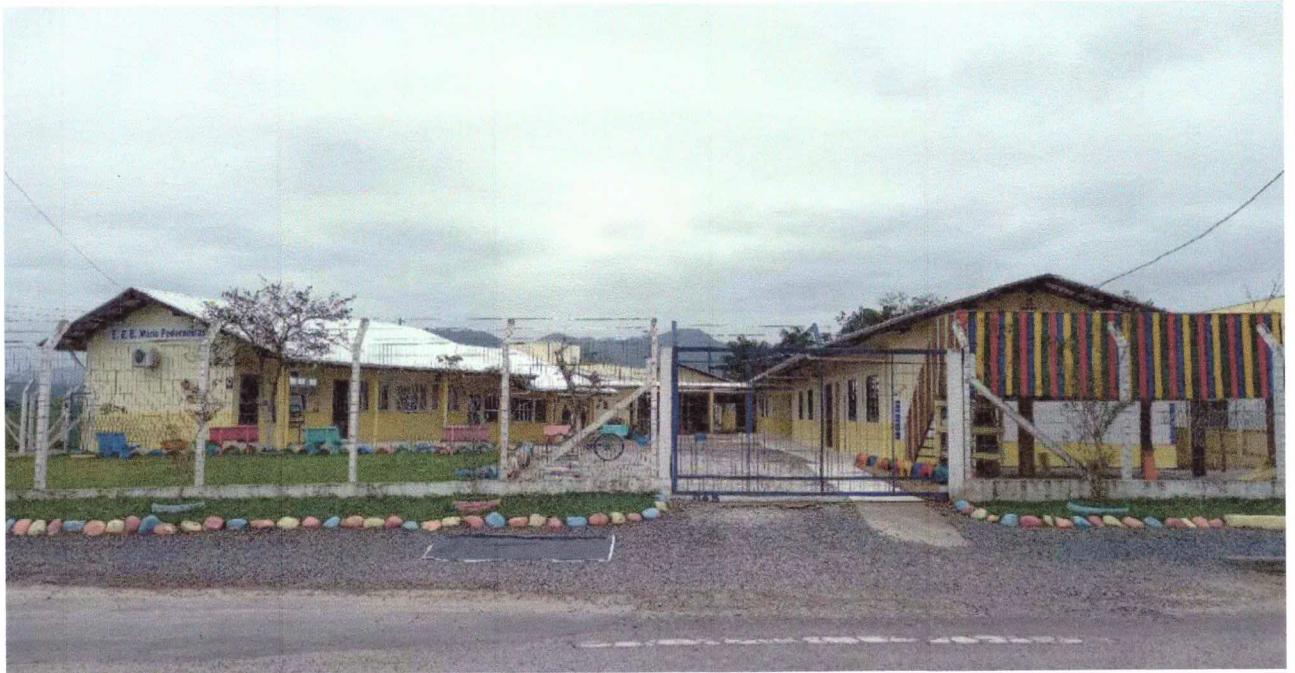
IMAGEM FACHADA DA ESCOLA
